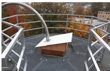
Trémie de remplissage avec soufflet de chargement
