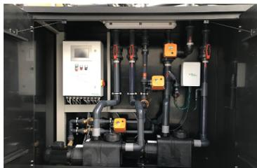
Générateur de saumure avec système de réservoir
