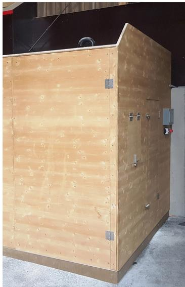
Générateur de saumure performant et entièrement automatisé (8'000 l/h) et réservoir de saumure d'un volume de 40'000 l
