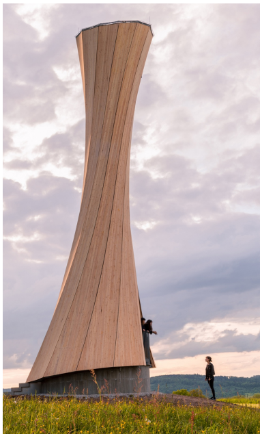
Une façade en mélèze enveloppe la tour
