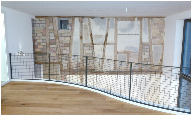
Rénovation de l'ancienne maçonnerie
