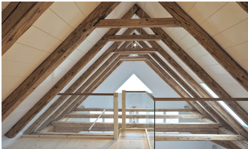
Charpente rénovée et agrandie
