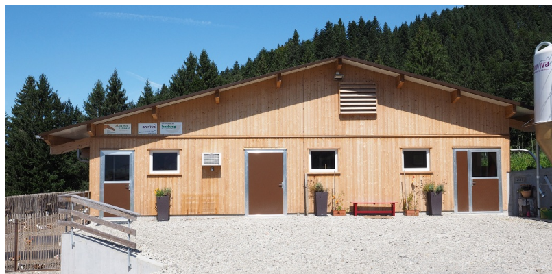
Façade avant avec bardage en sapin et épicéa
