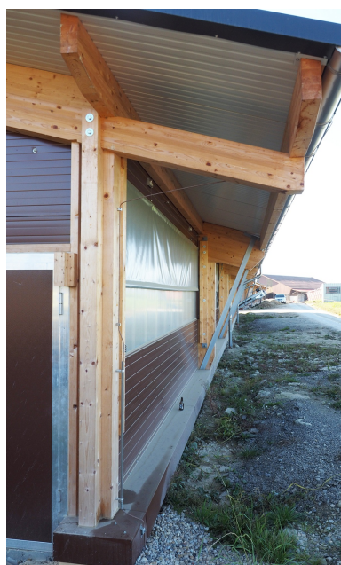
Vue détaillée de la toiture
