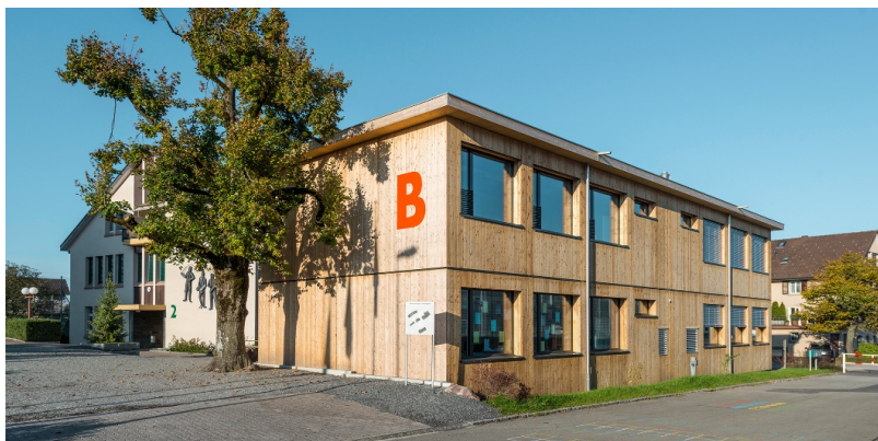
Construction modulaire à deux étages et façade en bois
