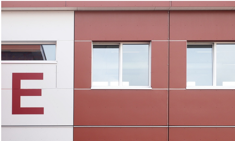
Détail de signalisation du bâtiment
