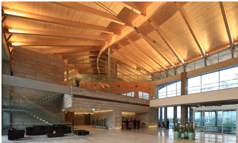
Structure de plafond courbe en forme de feuille
