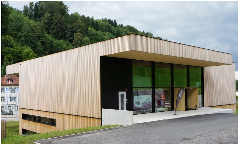
Zone d'entrée des locaux de vente
