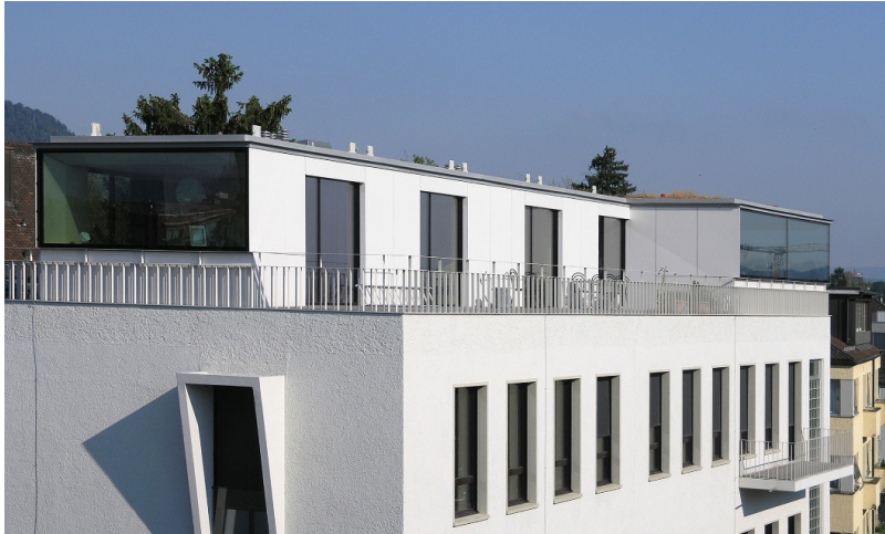
Rehaussement d'un étage en attique
