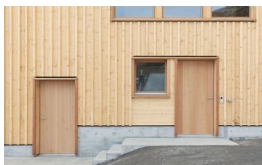
Le restaurant en libre-service dans le nouveau bâtiment en bois sur l'alpage de Carmenna.
