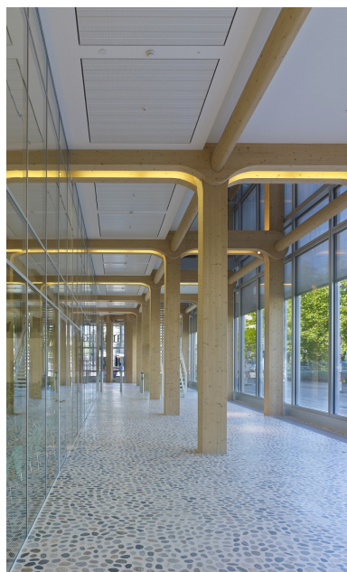
Structures porteuses apparentes à l'intérieur du bâtiment
