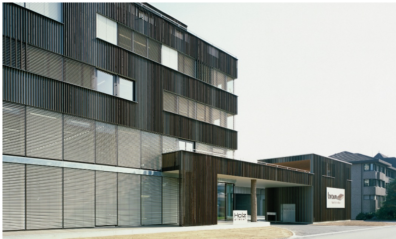
Zone d'entrée d'immeuble de bureaux
