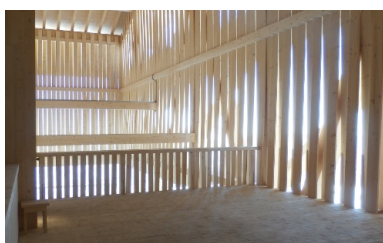
Vue détaillée de la construction en bois
