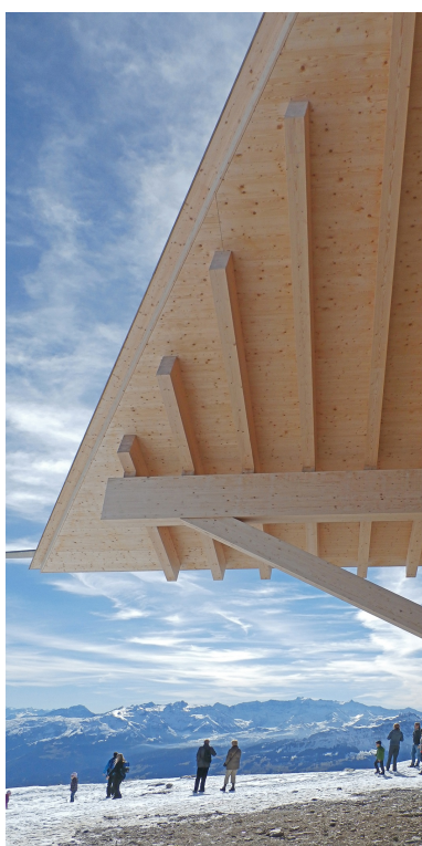
Vue détaillée de la toiture
