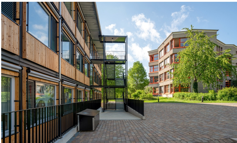
Die Geschosse des Schulpavillons werden mit einem externen Treppenaufgang erschlossen.
