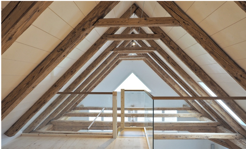
Dachstuhl saniert und ausgebaut
