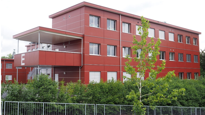
Akzentuierte Farbgebung der Fassade
