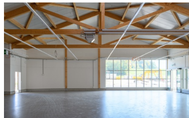
Sichtbare Holzkonstruktion im Innern
