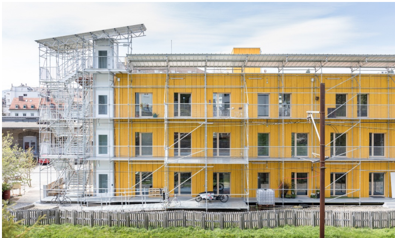
Erschließung über externen Laubengang
