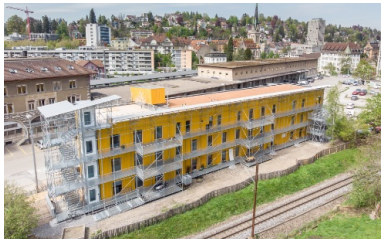
Urbane Lage direkt am Bahngleis
