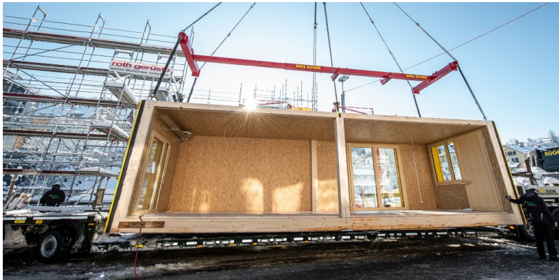
48 Module bilden den Lattich Bau in St. Gallen
