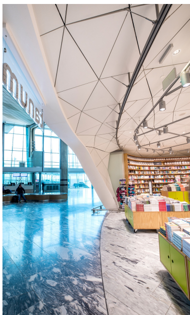
Detailansicht verkleidete Holzkonstruktion
