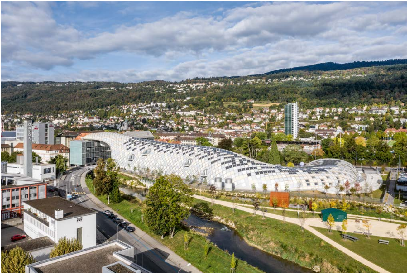
Spektakuläres Freiformtragwerk aus einer gigantischen Holzgitterschale: Der 240 m lange Neubau windet sich entlang der Schüss.
