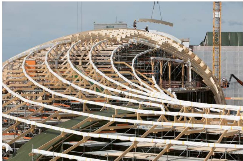
Montage der 11 000 m 2 grossen Holzgitterschale.
