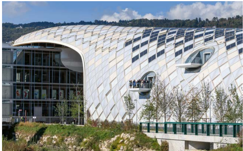
Wie Schuppen schmiegen sich die ins Gitterwerk integrierten Waben der Gebäudehülle um das Volumen. Neun Balkone erlauben den Gang an die frische Luft.
