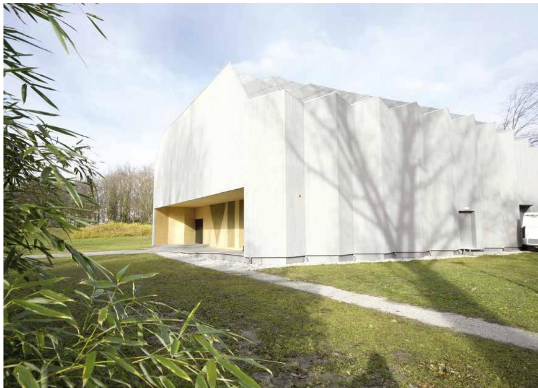
1 et 2. Le nouveau pavillon du Théâtre Vidy-Lausanne dialogue avec le bâtiment conçu en 1964 par Max Bill.
