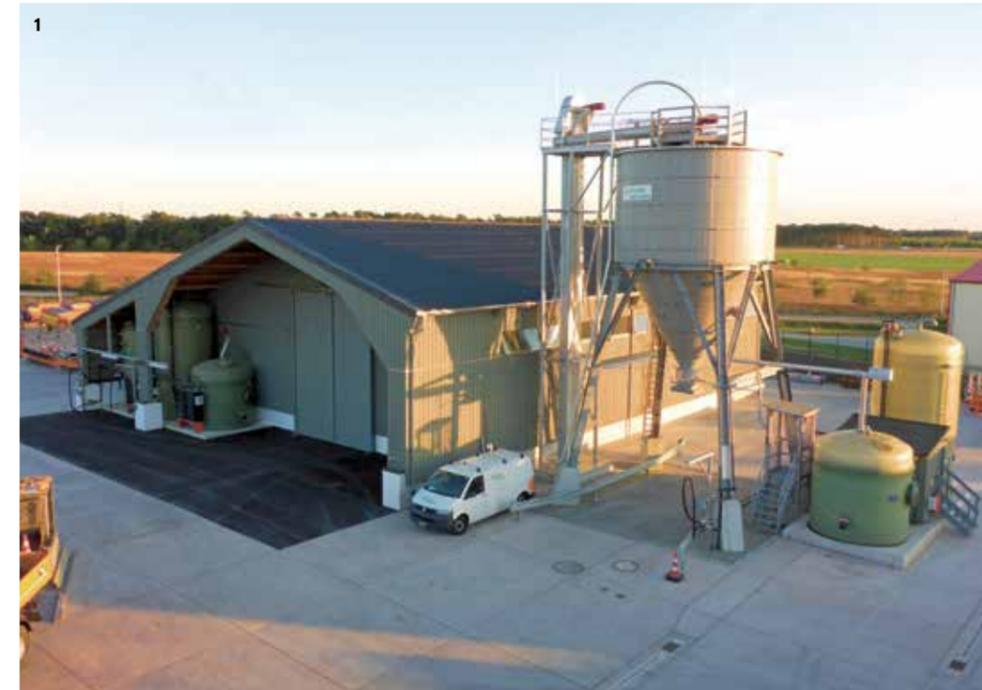
1 Fahrbinde (DE), Gesamtanlage mit Salzlagerhalle, 1 × 100 m<sup>3</sup> Rundsilos, Soletechnik und Fördertechnik
