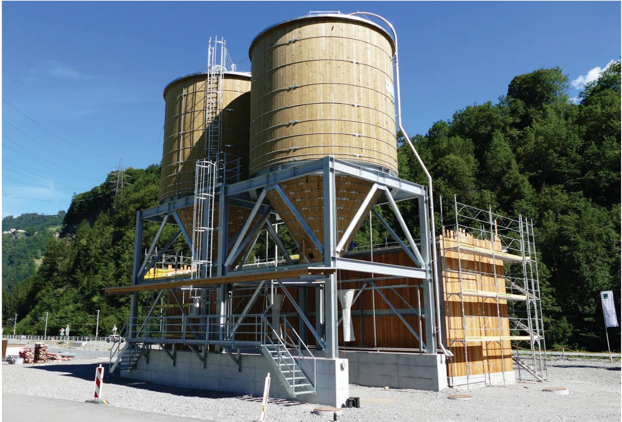
Die Siloanlage des neuen Unterhaltsstützpunktes Küblis in runder Bauform ist auf einem kubischen Stahlunterbau errichtet.
