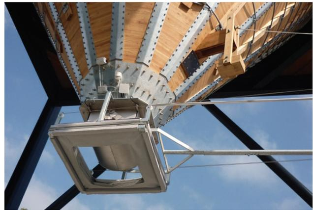
Der zwölfckige Plattensilo aus Lärche ist auf einem kubischen Stahlunterbau errichtet.
