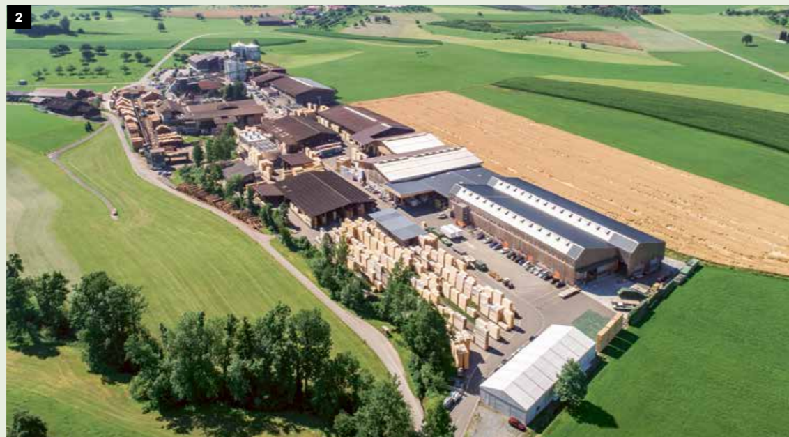
2 Proizvodno mesto Erlenhof, Gossau SG (CH)
