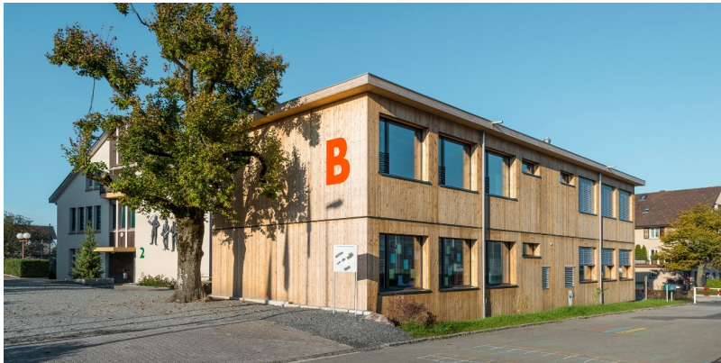
Zweigeschossiger Modulbau mit Holzfassade
