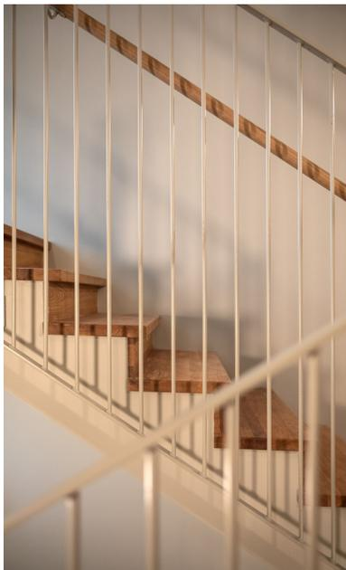
Für die Treppenkonstruktion wurde Eiche verwendet.
