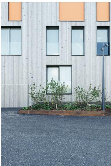
Fassadenansicht der Schlösslipark-Wohnbauten. Die raumhohen Fenster bauten wir schon bei der Produktion in unserem Werk direkt in die Wandelemente ein.
