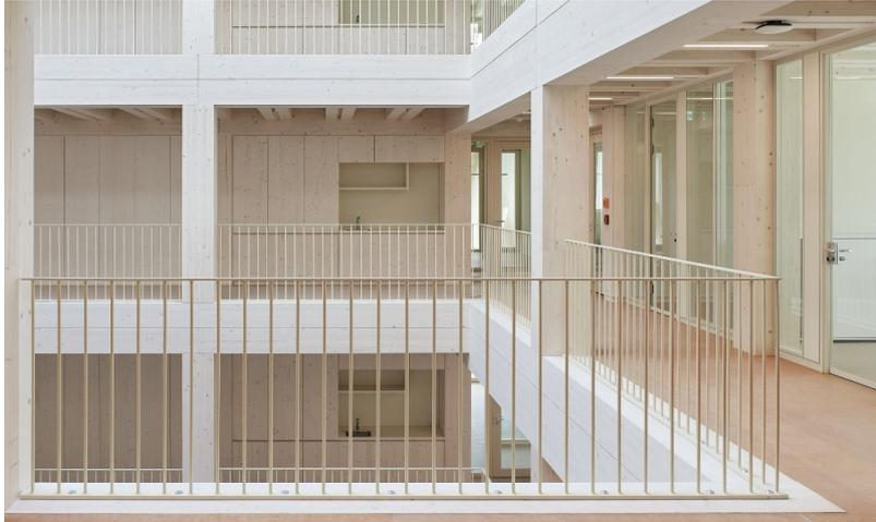
Die Fachwerkstruktur des Holz-Hybrid-Gebäudes verleiht dem Bauwerk sein unverwechselbares Aussehen und dient gleichzeitig der Aussteifung des Gebäudes.
