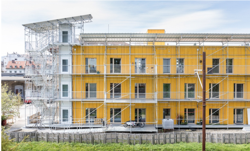
Erschliessung über externen Laubengang
