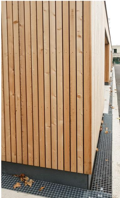
Vertikal verlegte Lärchenholzplatten bilden die Fassade.
