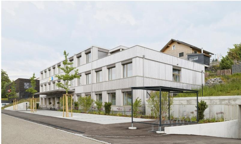
Die Fenster, Holzfassade, haustechnische Installationen einschliesslich elektrische und Sanitärinstallationen wurden in unseren Produktionshallen bereits vormontiert.
