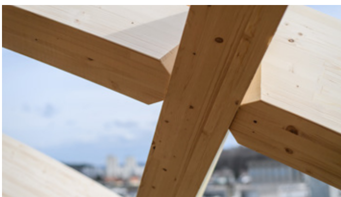
Bauteile weisen eine Passgenauigkeit von einem Zehntel Millimeter auf.
