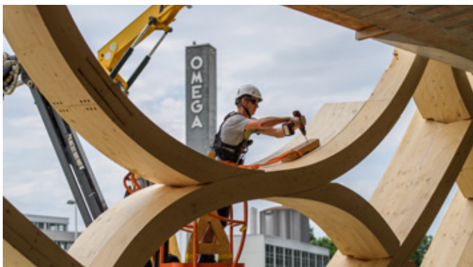
Arbeit an der Holzgitterschale des Swatchgebäudes.
