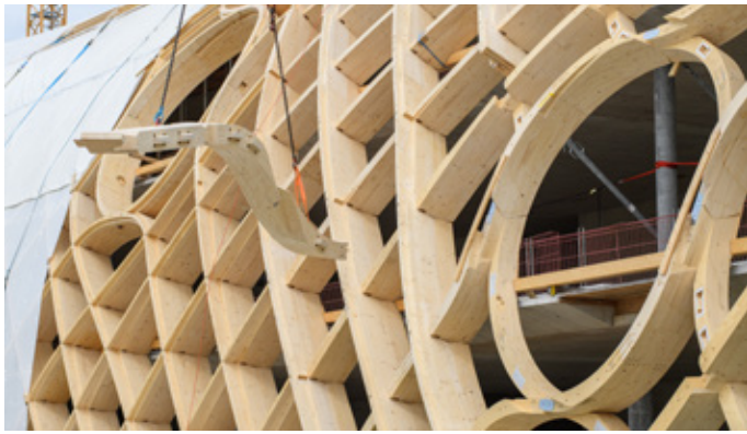
Ein Holzträger wird per Kran an seinen Bestimmungsort gehievt.
