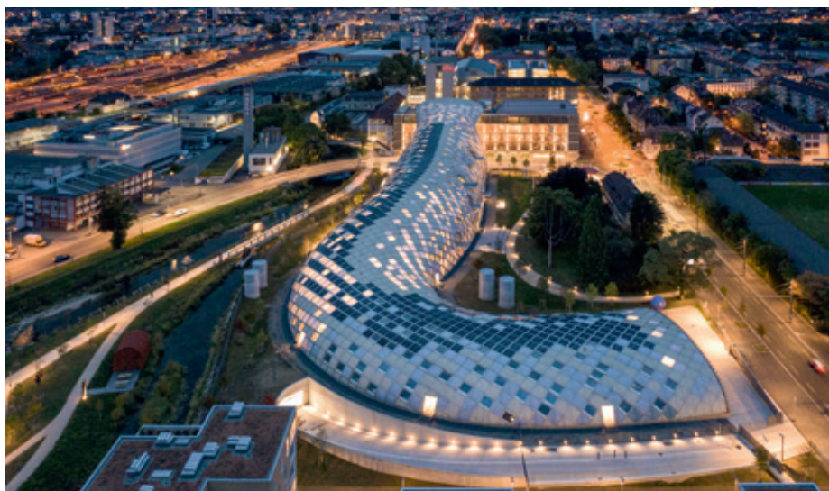
Eindruckliche Nachtaufnahme des «Drachen von Biel». Die Gebäudehülle schützt die darunterliegende wabenförmige Holzkonstruktion.
