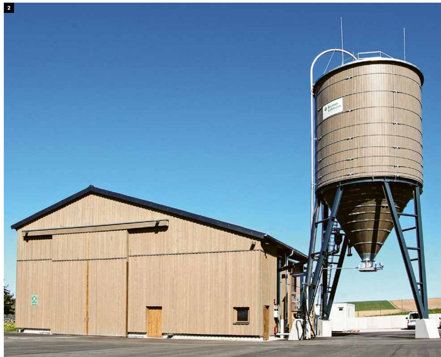
1 Fahrbinde (DE), impianto completo con magazzino di sale, 1 silo rotondo da 100 m 3 , tecnologia ad acqua salina e tecnologia di trasporto 2 Bad Rappenau (DE), impianto completo con magazzino di sale, tecnologia di trasporto ed 1 silo rotondo da 200 m 3
