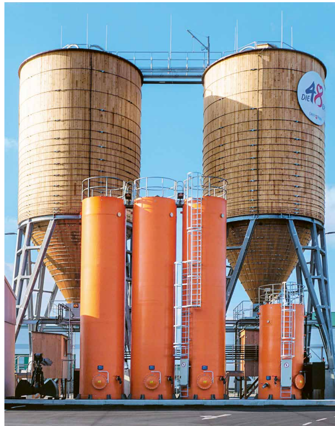
Vienna (AT), 2 silos rotondi da 500 m 3 e 3 serbatoi di acqua salina con generatore di acqua salina da 45 m 3 .
