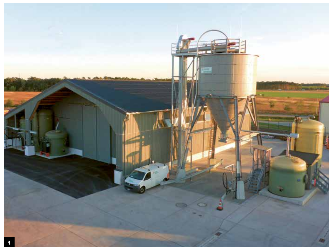
1 Fahrbinde (DE), impianto completo con magazzino di sale, 1 silo rotondo da 100 m 3 , tecnologia ad acqua salina e tecnologia di trasporto 2 Bad Rappenau (DE), impianto completo con magazzino di sale, tecnologia di trasporto ed 1 silo rotondo da 200 m 3
