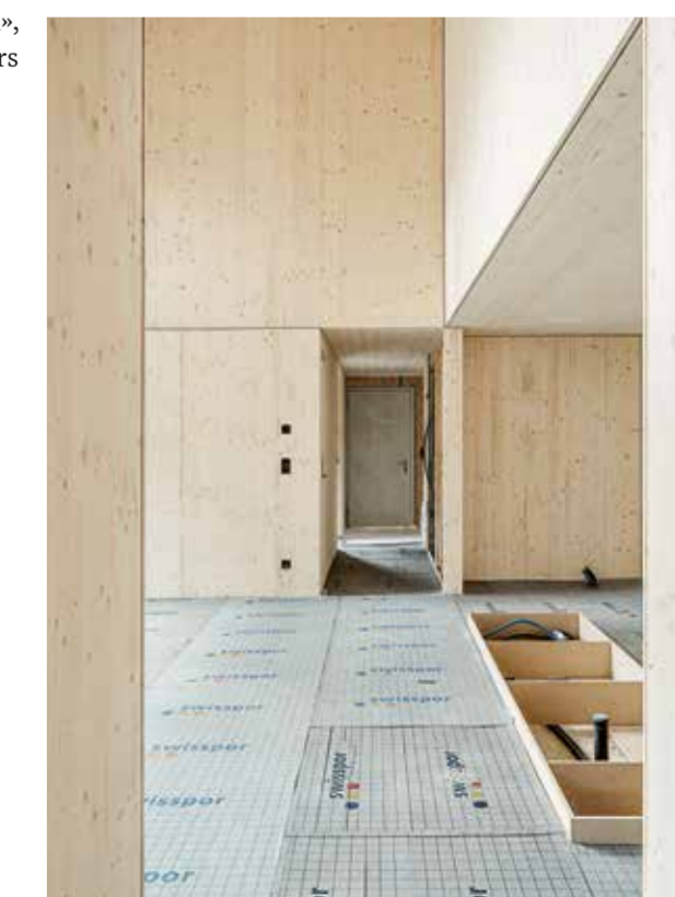
Des panneaux 3-plis en épicea prédominent l'aménagement intérieur.
