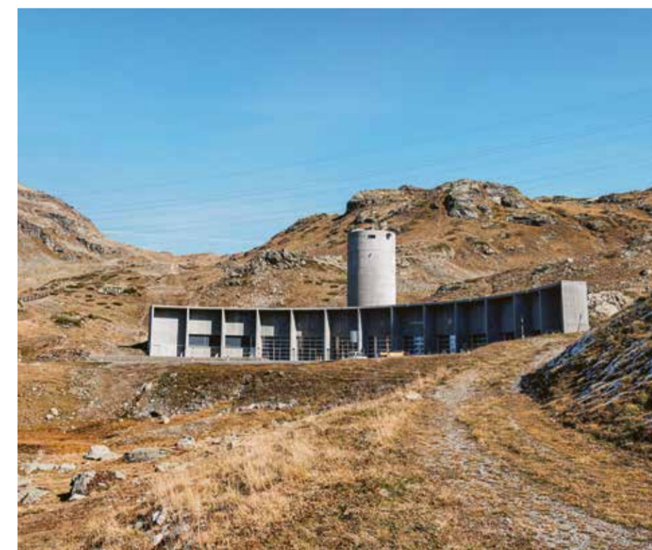
En haut: grâce à sa construction de forme semi-circulaire, la base d'entretien s'intègre parfaitement au compartiment de terrain existant.
